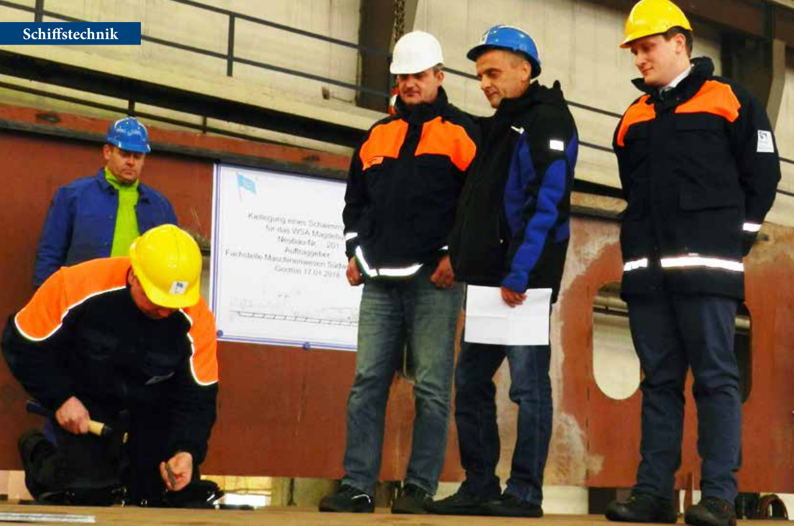
Das Einschlagen der Baunummer ist gleichzeitig der Start für den Neubau des Baggerschiffes
