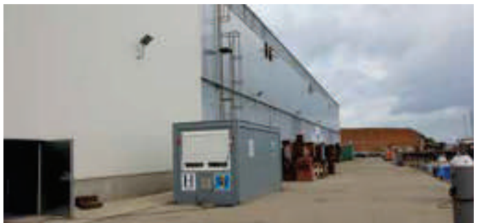
Von außen ist gut zu erkennen, ab wo der Neubauteil der großen Halle beginnt
