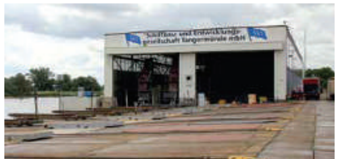
Blick über die Helling zu der erweiterten Schiffbauhalle | Bilder: Nutsch
